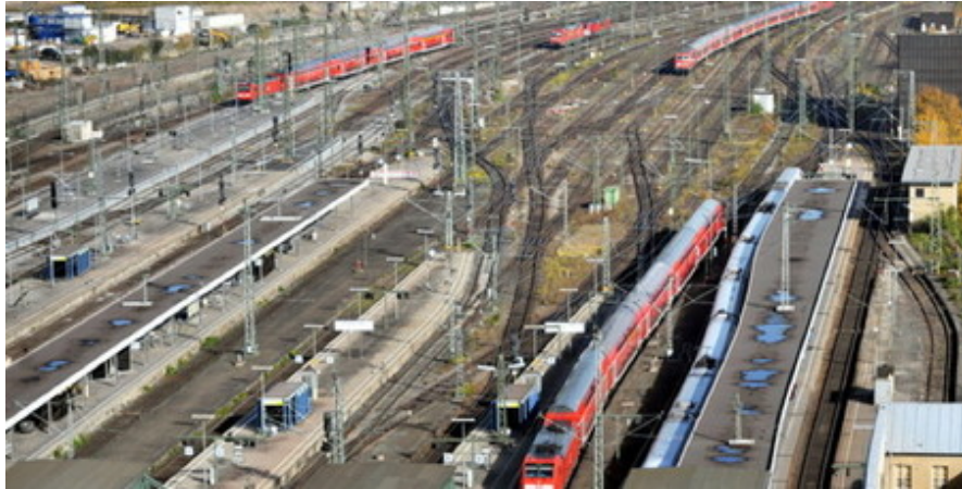
Könnten weiter befahren werden: Gleise in Stuttgart.
